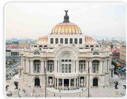
Fig. 3.31 La construcción del Palacio de Bellas Artes (con claras influencias francesas, de Art Nouveau y Art Decó) comenzó en 1904, como uno de los edificios conmemorativos del centenario de la independencia.
